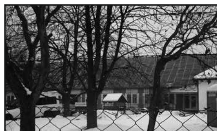
Pöttömke Óvoda épülete a Rákóczi úton, tetőfedés nélkül, óvodai nyitvatartás alatt
