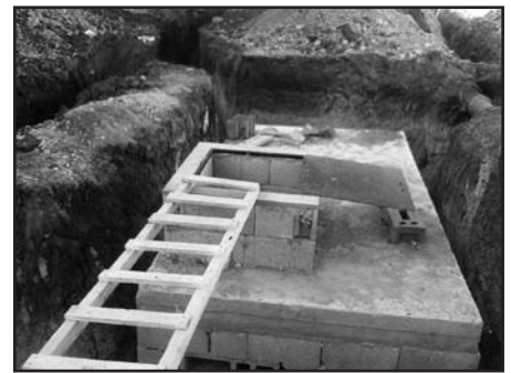
Földhő hasznosító berendezés építése
